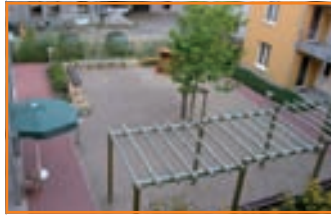
Die fünf Gebäuderiegel bilden einen Innenhof, der ebenfalls Raum für Gemeinschaftsleben bietet.
