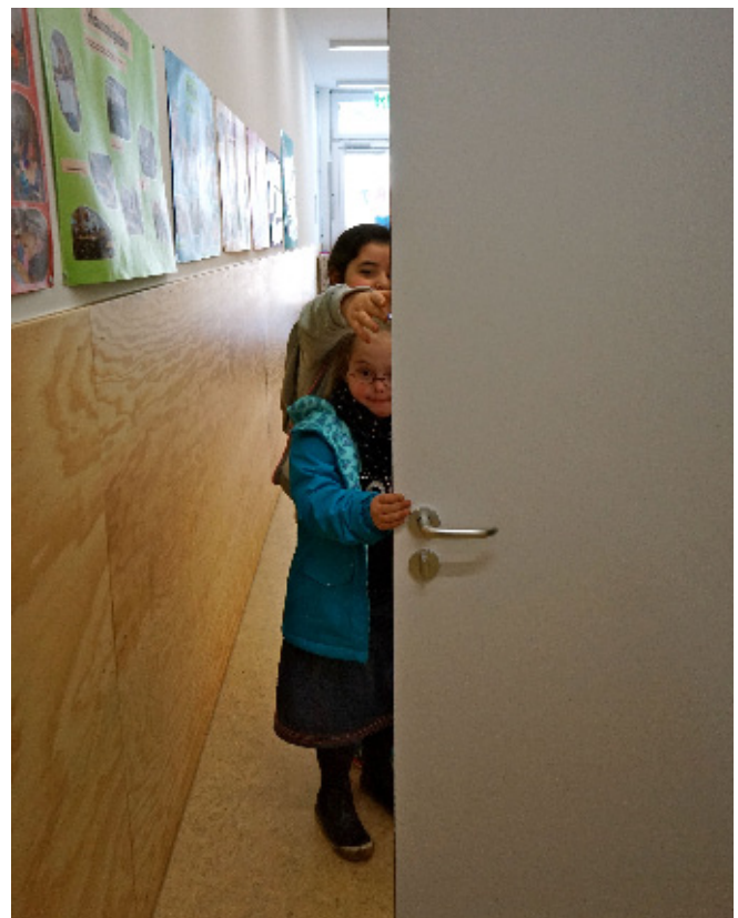
Abb. 1: Vor dem Umbau ragte die normalbreite Tür weit in den Flur – eine Gefährdung für Kinder und Erwachsene. Außerdem fehlten Rangierflächen.
