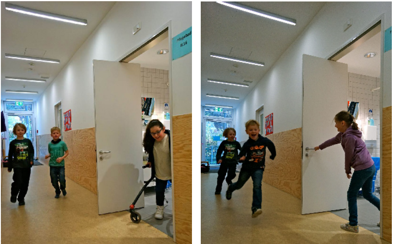
Abb. 2: Die Raumpartür verhindert Gefahren durch aufschlagende Türflügel. Außerdem vereinfacht der geringe Greifabstand zum Türgriff den Alltag für alle.
