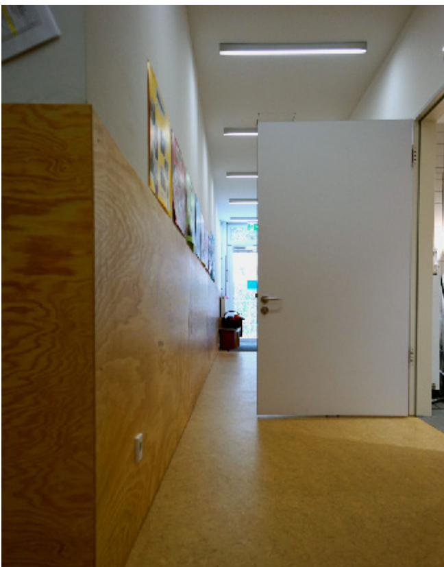
Abb. 1: Vor dem Umbau ragte die normalbreite Tür weit in den Flur – eine Gefährdung für Kinder und Erwachsene. Außerdem fehlten Rangierflächen.
